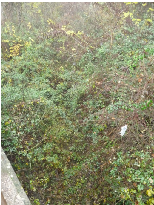
Slika 9: Struga Piševca (lokacija most na cesti Koper-Dragonja-gorvodno)
