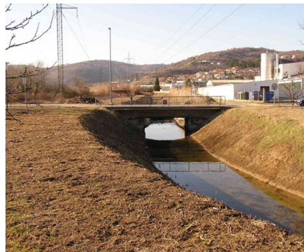
Slika 8: Obstoječi most na Vanganelski cesti
