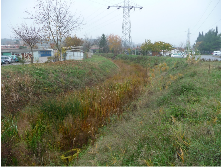
Slika 14: Struga Pjažentina-dolvodno (lokacija Šalara)
