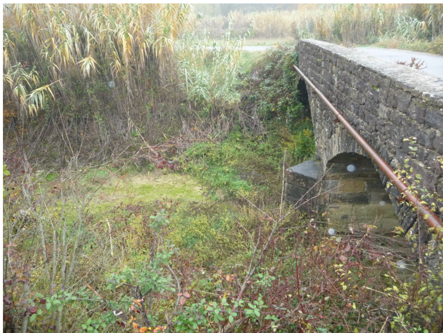
Slika 2: Struga Drnice-most gorvodno (lokacija-cesta proti Kortam)
