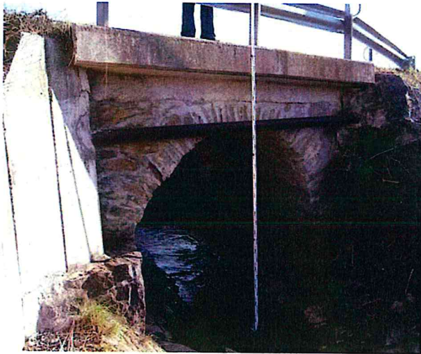
Slika 9: Obstoječi most na območju Tribanske ceste
