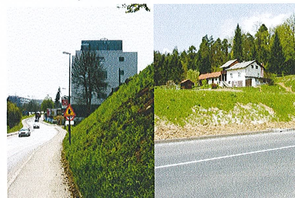
objekti tovarne zdravil Krka, kot obulični niz visokih stavbnih mas domačija, razpršena gradnja že nad "robom mesta"
